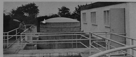
Installations à Pradic Glaz.
