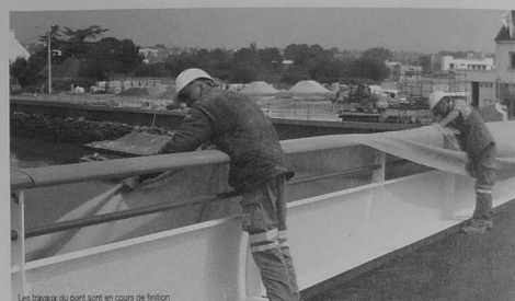
Les travaux du pont sont en cours de finition.
