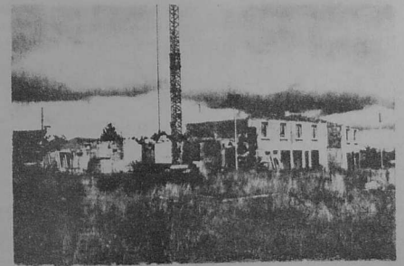
1971 : le chantier arrêté
