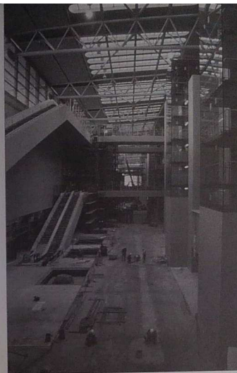
Chantier vu de l'intérieur.
