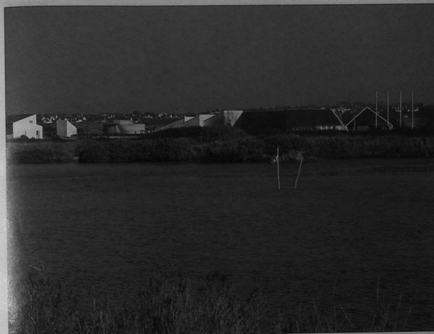
La station d'épuration de Livery. Guérande en arrière plan.
