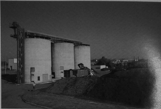
Station d'épuration de Tougas (Saint-Herblain): les 47 m 3 de boues récupérés quotidiennement sont valorisés sous la forme de compost. La station en produit environ 8 000 m 3 /an.
