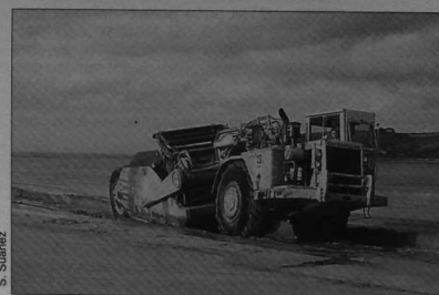
Ouverture du chenal artificiel du Yar à l'aide d'un engin de type "éplucheur".
