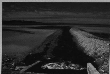
Armement des levées de berge du Yar par la construction de bourrelets constitués du produit de curetage de fond de lit. La même opération a été menée sur les rives du Roscoat afin de contenir les deux cours d'eau dans un tracé rectiligne.
