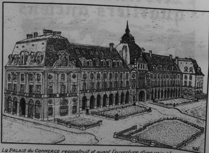
Le PALAIS du COMMERCE reconstruit et avant l'ouverture d'une voie à la circulation
