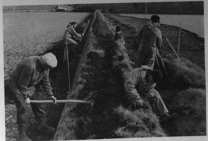
Ecole des talus, St Thonan ; travail sur les derniers mètres.
