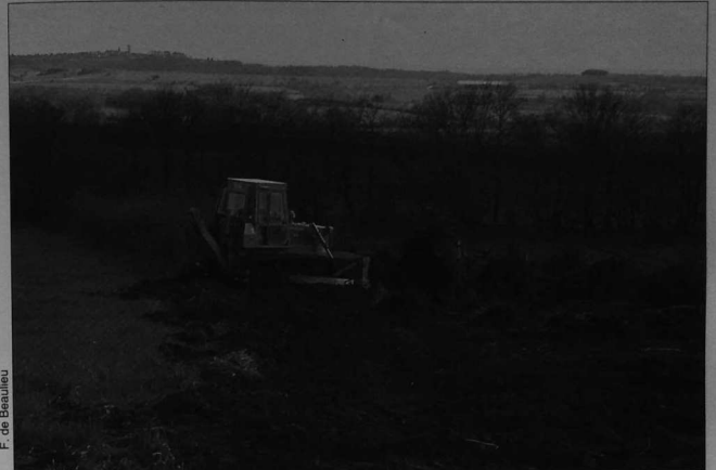
Destruction de talus au bulldozer à Plougonven (Finistère).
