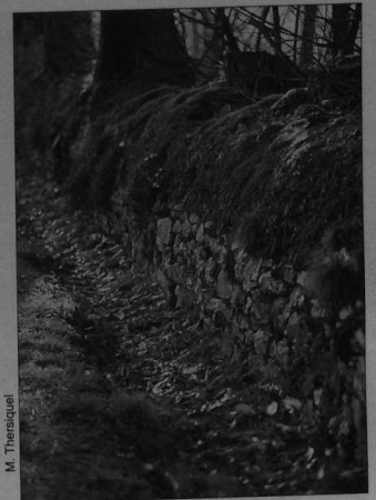
Talus avec "breoill" à St Cadou.
