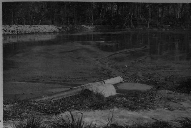
Refoulement des vases et sédiments dans une lagune de décantation.
