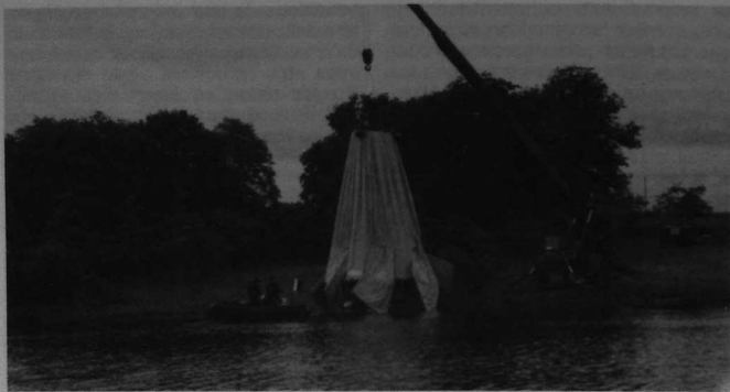
Mise à l'eau d'un aérateur d'hypolimnion à la retenue de Moulin Ribou (Maine-et-Loire).
