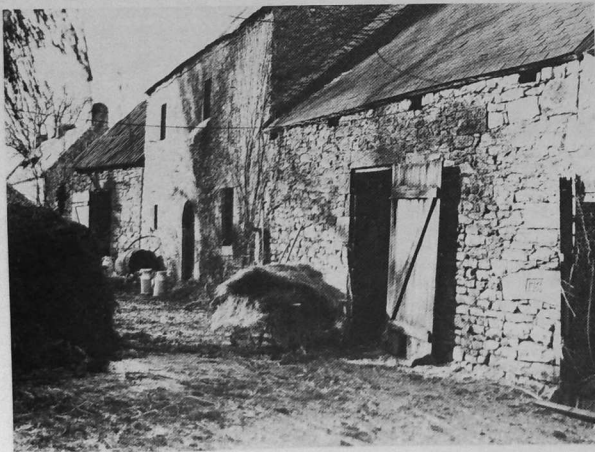
Fig. 5. — Sainte-Marguerite en Logonna-Daoulas. Bâtiment de ferme du 18 e siècle construit en microdiorite quartzique. Seule la pierre portant la date de construction est en kersantite.
