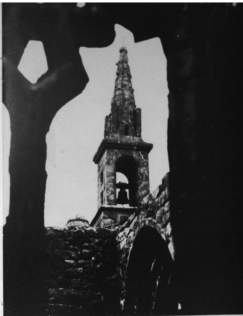
Le clocher pris au travers de la fenêtre Est de la chapelle latérale
