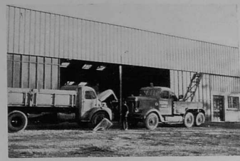
Garage SERVIA, nouvelle unité sur la zone industrielle (Photo ROGER-ROBERT)
