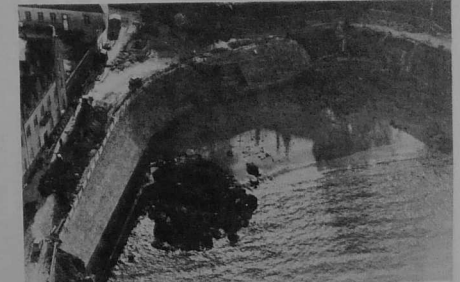
Les travaux du boulevard Richepin devant la plage de PORS-CAD.
