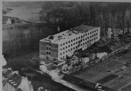
La nouvelle unité de soins en construction aux Plomarc'h (photo Le Brusq)
