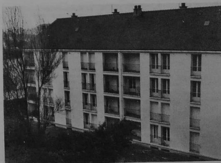
H.L.M. en construction rue Ernest Renan (photo Le Bruq)
