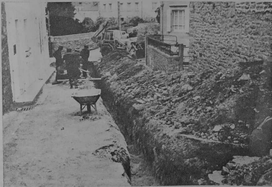
Les travaux rue de la Marne
