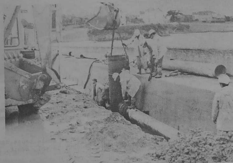
La pose de l'émissaire du Flimiou
