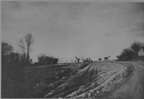
Le début des travaux
