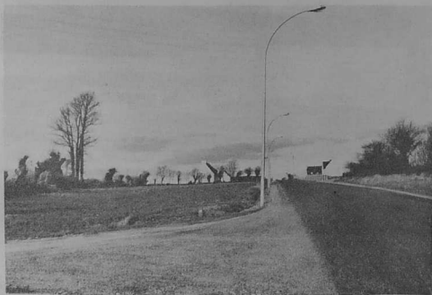
La voie terminée
