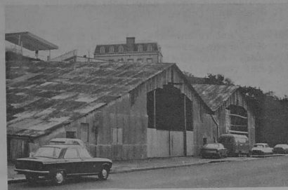
Les chantiers Le Gall avant leur récente démolition
