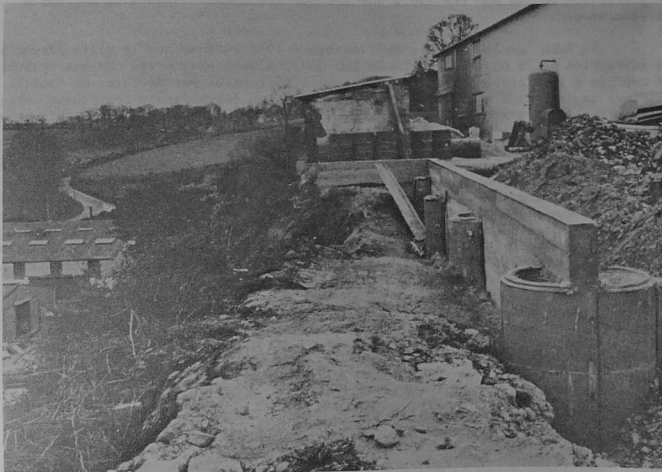
Les travaux réalisés en 1977
