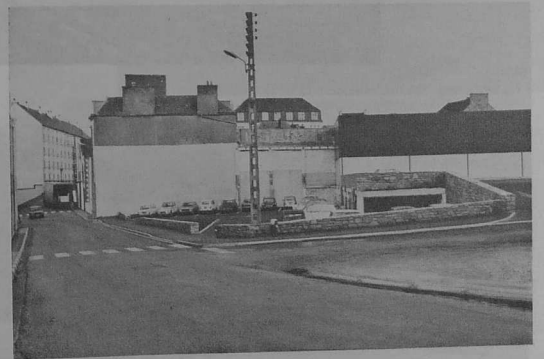
Le parking terminé
