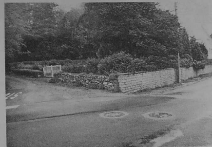
Le mur avant les travaux
