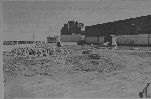
Une phase des travaux
