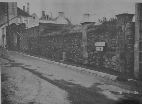
La rue des Plomarch où sera bientôt réalisé un parking.
