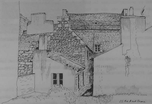
Arrière maison du 25, rue Anatole France. Les constructions seront démolies pour laisser la place à un jardin public.
