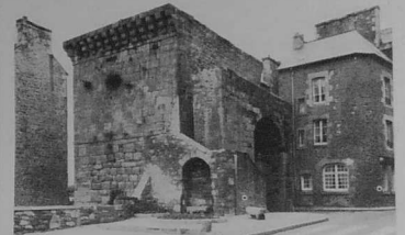
La Porte Saint-Louis, après démolition de l'immeuble Labarthe (Photo Daniel CAVAN)
