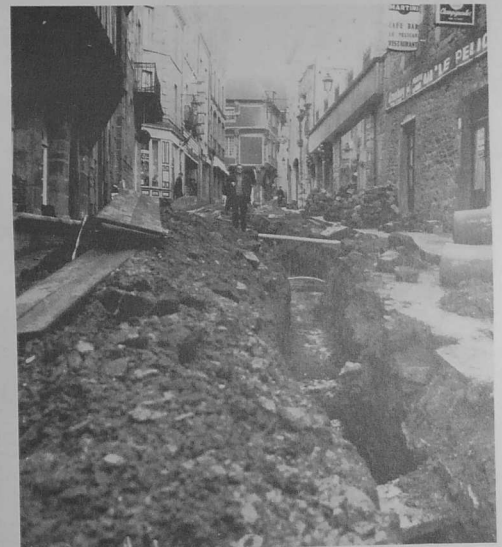
1966... les travaux de réfection des collecteurs d'égouts, rue Haute-Voie
