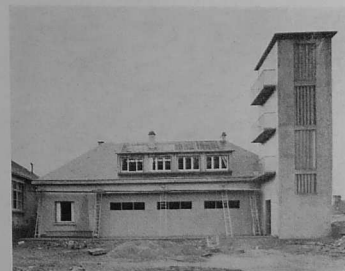
Local des pompes à incendie.
