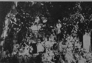
Les fusillades se sont déroulées contre le mur d'enceinte, au nord de la propriété.
