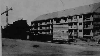
Les H.L.M. du Home Atlantique Le logement des quatre chambres sera construit au Chapeau Berger, rue du Bouquetier de l'Europe
