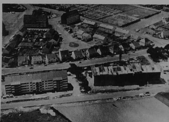
H.L.M. du Home Atlantique - 2 des 3 immeubles locatifs en construction, rue du Bouquetier
