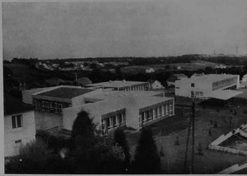
Le Groupe scolaire de la rue de la Mère.
