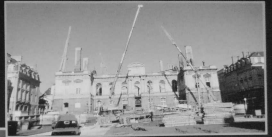
Etat après l'incendie
