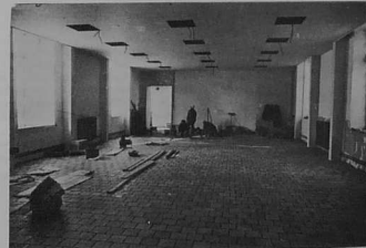
Le Club des personnes âgées en cours de travaux.
