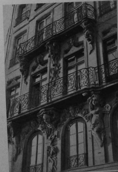
54. Vieux balcons du quai de la Fosse. Photo Duguy.
