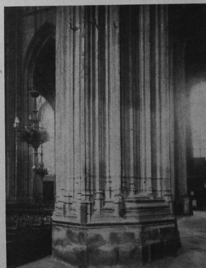
31. Soubassement des piliers de la nef.
