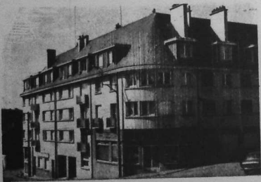
ENTREPRISE GENERALE DU BATIMENT
