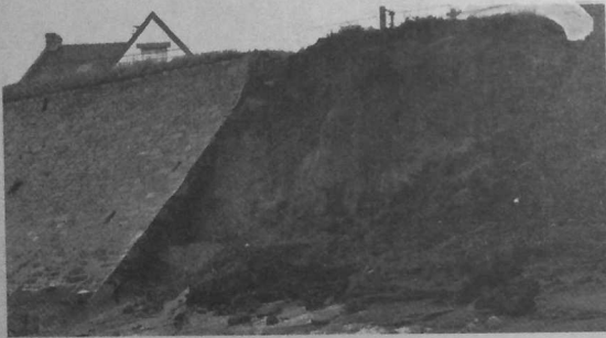
Photo n° 1 : l'extrémité Est du mur de soutènement de la D 99 à Lérat.
