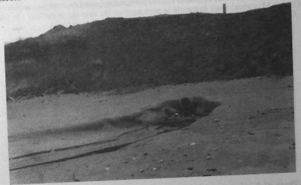
La sortie des eaux pluviales du lotissement Waroc'h sur la plage du sea-line, en arrière le remblai d'argile de protection (!) de la côte.
