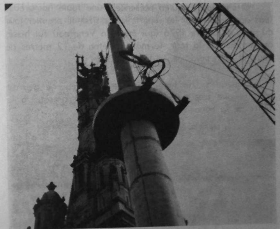
Le mât de béton est hissé lentement... (cliché Ouest-France).
