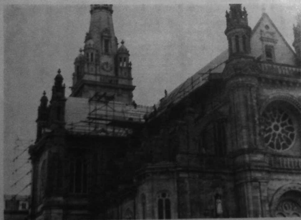
Les travaux de réfection du toit étaient avancés...
