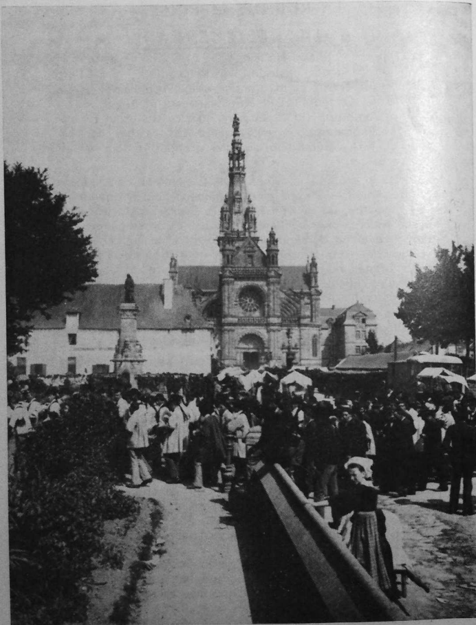
Un muret délimite le passage... (les photos illustrant cet article sont de la maison CROLARD, Lorient)
