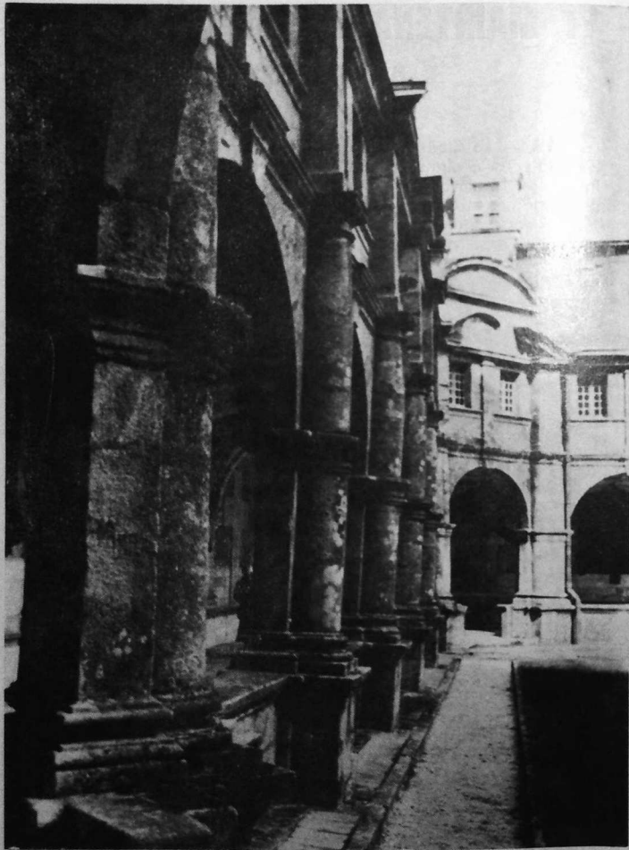
Sous la poussée de la voûte, les colonnes ont « joué » (Pèlerin no 273) (photo LE GUERNEVEL, Auray)
