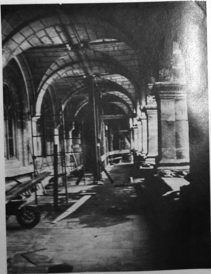
« Il faut étayer les quatre angles du cloître... » (Pèlerin n° 273, cliché page 10) (Photo LE GUERNEVEL, Auray)
