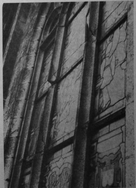
« ...ont fait éclater les meneaux (pierres verticales) » (Pèlerin n° 262, p. 95)
