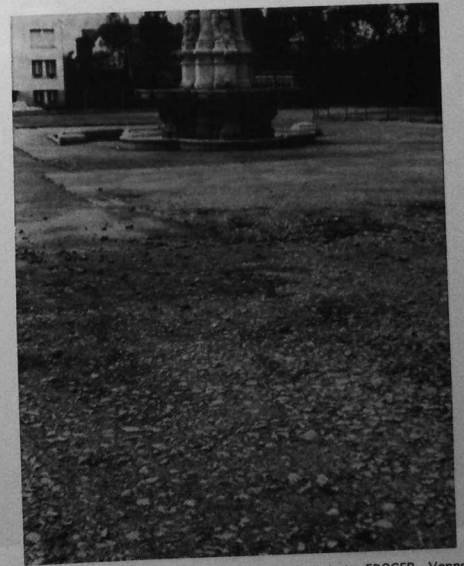
L'esplanade se dégrade très rapidement (Pèlerin no 264, photo FROGER, Vannes, page 15)
