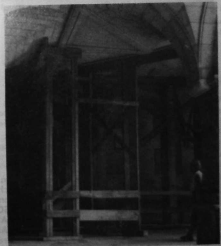
Il a fallu étayer chaque angle du Cloître (Photo : Froger, Vannes)
