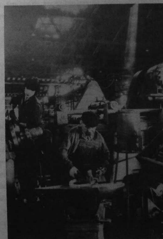
Aux forges et laminoirs à l'ancienne usine, bld Carnot
