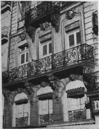
Maison du XVIII e siècle, quai de la Fosse. Photo Syndicat d'Initiative
