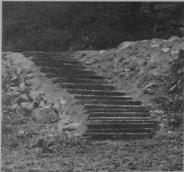
Aménagement d'escalier au Grand Rocher.
