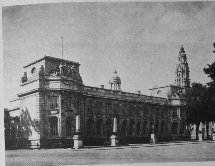
Les Cours de Justice de Cardiff sont installées dans un édifice d'architecture de style néo-classique avec une façade faite en pierre de Portland. La tour de l'horloge est au-dessus de la mairie; pouvez-vous la trouver sur la photographie aérienne de Cardiff ?
