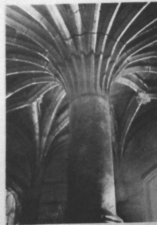
Terminaison du grand escalier de la tour de la Couronne d'or.
