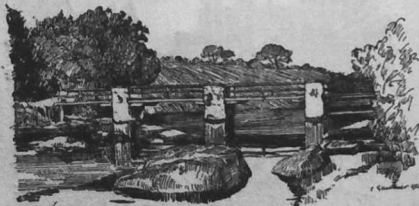
Clisson. — Le Pont de l'Arsenal sur la Sèvre
