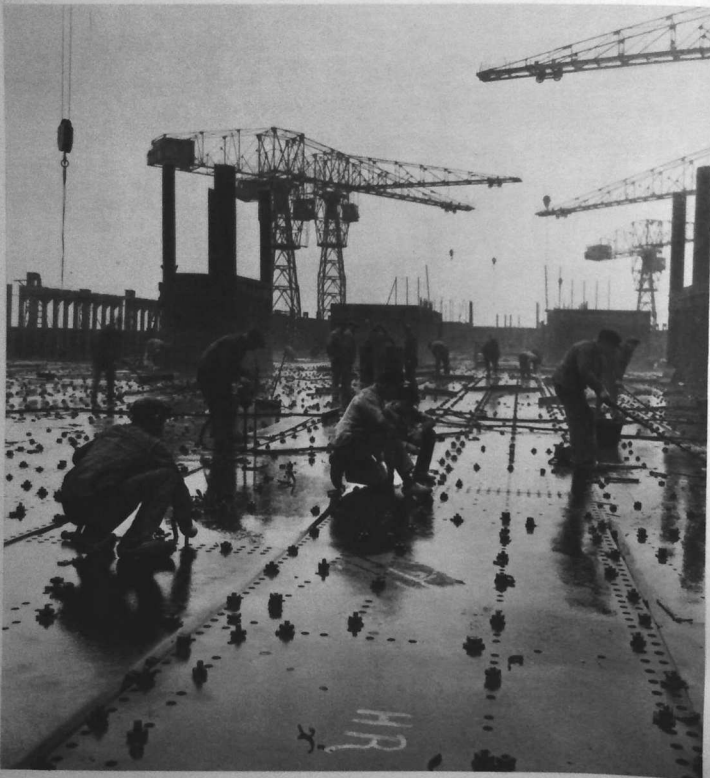
Le rivetage des tôles d'un pont du Super-Ile-de-France.
