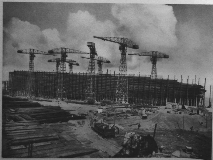
Vue longitudinale du Super-Ile-de-France, lors de sa construction aux chantiers de Penhoët. A 50 mètres en plein ciel se profilent les gibets des grues.
