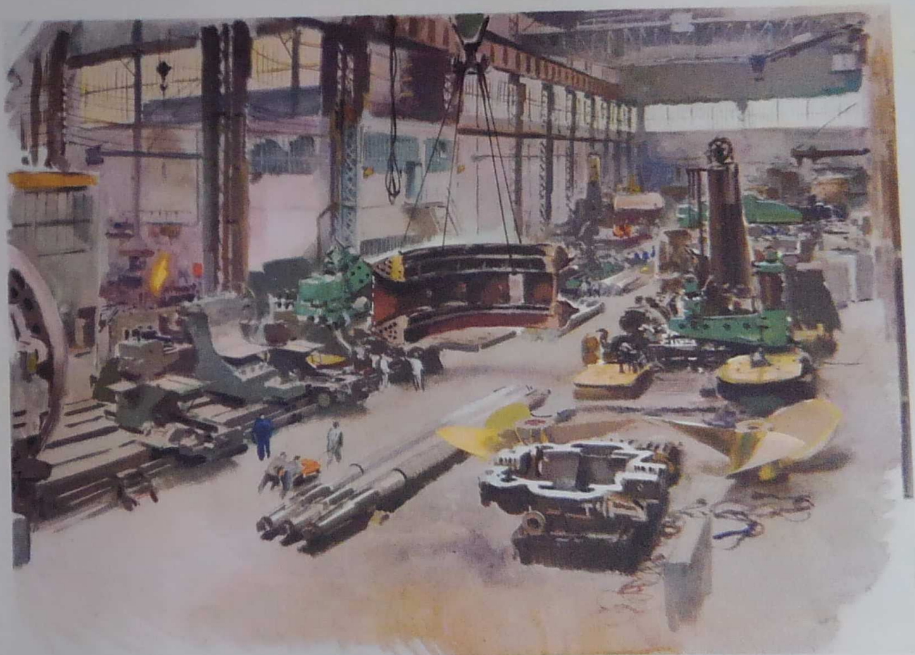
Atelier des turbines.
