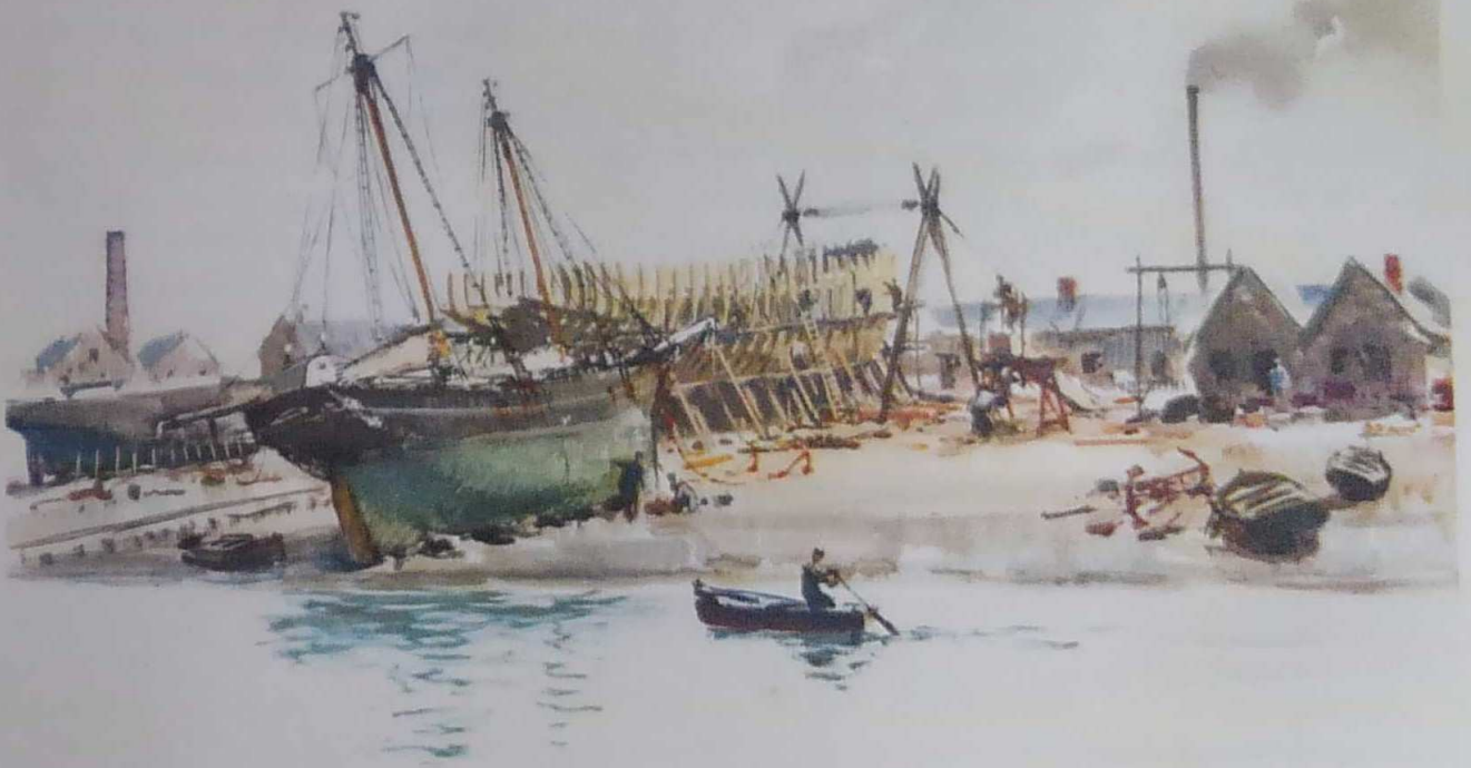
Les chantiers Jollet et Babin à Nantes vers 1878.
