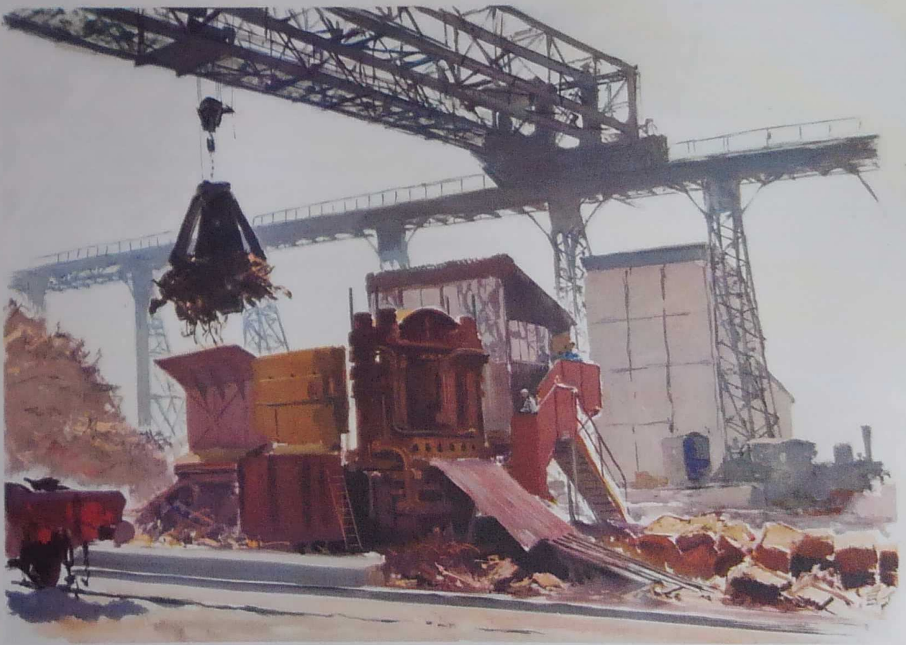
Presse à paqueter les déchets métalliques
