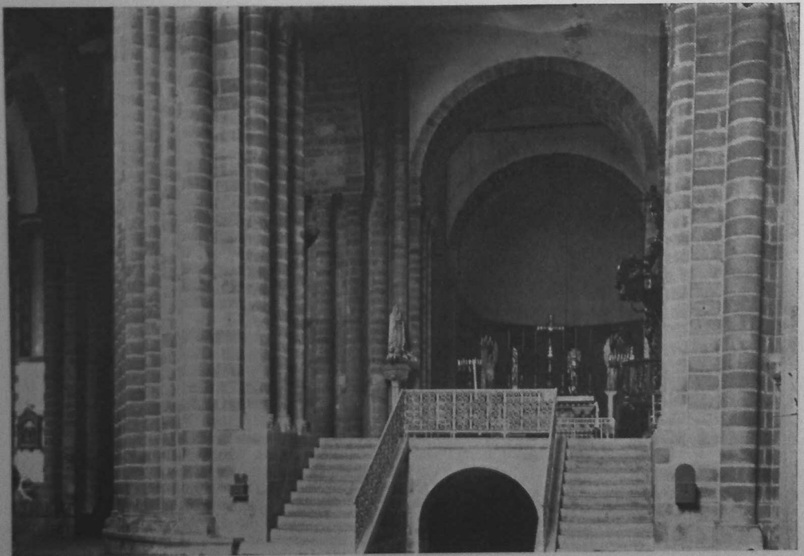
INTÉRIEUR DE SAINTE-CROIX DE QUIMPERLÉ (FINISTÈRE)
