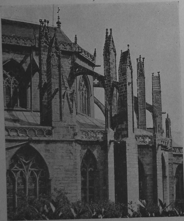
CATHÉDRALE DE QUIMPER Contreforts et arcs-boutants de l'abside
