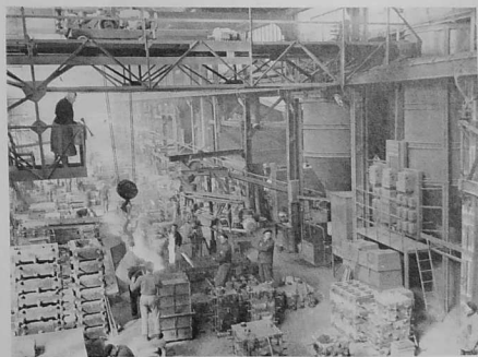
Le pont roulant permet la manutention rapide des pièces les plus volumineuses.
