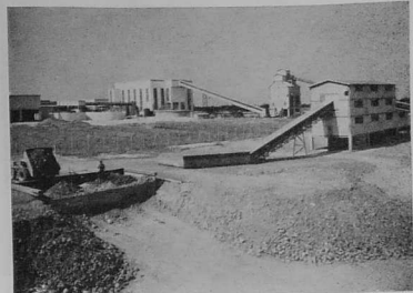
L'ENSEMBLE DES INSTALLATIONS DE L'USINE DE TRAITEMENT
