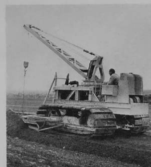
LE RATISSAGE OBLIQUE FORME UN CORDON DE TOURBE
