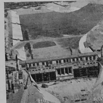
Vue aérienne de la Centrale en cours de construction avant l'achèvement du canal d'aménagement. On distingue en premier plan le canal de fuite.
