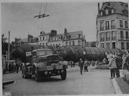
Les installations SHELL-BERRE
