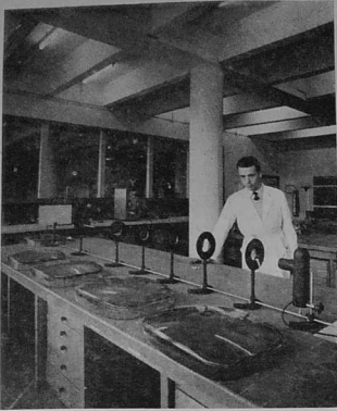
Fabrication des canalisations. — La production en grande série, la normalisation des gammes de fabrication permettent de répondre aux demandes sans cesse croissantes. Treize longueurs standard droites de canalisations entre 100 mm, et 3 mm, chacune dans six diamètres de 1" à 6", les dimensions non standard, les raccords autorisent la réalisation de toutes installations. La fabrication du tube consiste en un étirage mécanique du verre ; le soufflage à la bouche dans des montes est encore utilisé pour de gros diamètres par exemple. Quant à la transformation et à l'assemblage par soudure de certains éléments de verre, ils sont obtenus par façonnage ou chaloumeau.
