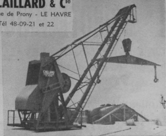
Grue de mise à l'eau du canot de sauvetage de Granville
