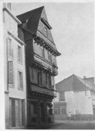
CARHAIX - Maison ancienne
