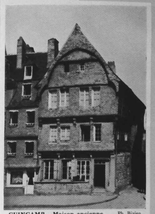
GUINGAMP - Maison ancienne Ph. Bizien
