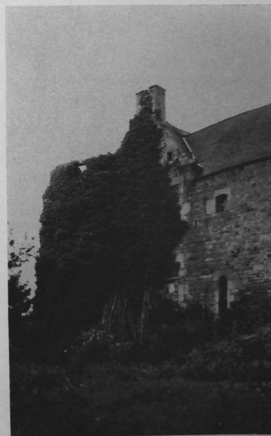
LESTREZEC. — RUINES D'UNE TOUR APPELÉE LE « DONJON »
