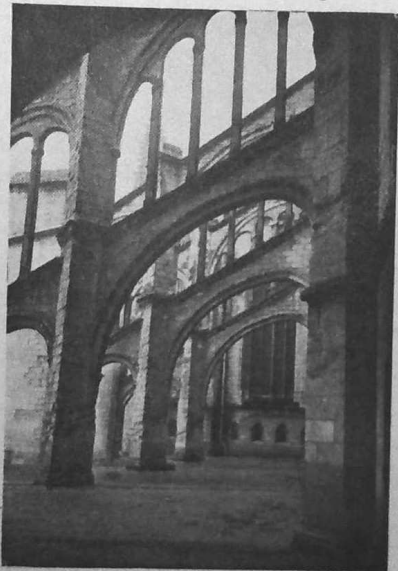
Les arcs-boutants (côté nord)
