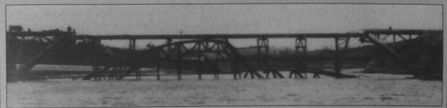
Passerelle provisoire, mise en place en mars 1947.
