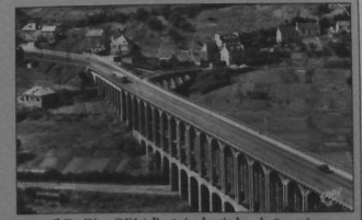
Autorail De Dion OCI à l'entrée du viaduc de Souzain.
