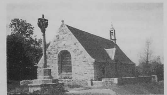
La chapelle de Kéloomad en 1992 après la restauration du mur d'entourage
