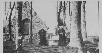
Les anciens étaient prévoyants en entretenant quelques arbres autour des édifices religieux pour remplacer la charpente, tous les 70 ans environ.
