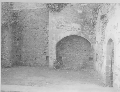
Chauffoir - mur sud
