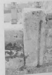
Fig 4 : Beauport, réfectoire : réemploi de claveaux d'ogives dans le parapet
