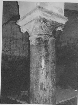
Fig 2 : Beauport, sacristie, support central colonne et chapiteau en lumachelle
