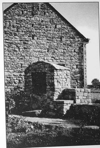
Grange du Bois : Aile nord avec le puits restauré (Photo A-C. Ballini)
