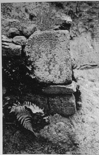
Angle nord-est du prieuré St Macaire. (Fondation mise à jour en 1996 par M. Jean-Baptiste Lemonnier) (Photo A-C. Ballini)
