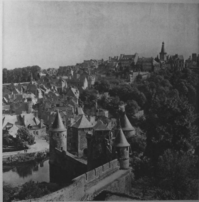
FOUGÈRES. COURTINE NORD ET ENTRÉE DU CHÂTEAU AU PREMIER PLAN. AU LOIN LA VILLE HAUTE DOMINÉE PAR LE BEFFROI (XIV e S.). De gauche à droite : les tours de Guémadeuc, de La Haye-Saint-Hilaire; en avant les tours de Coigny et de Guibé; en arrière la tour du Hallay.
