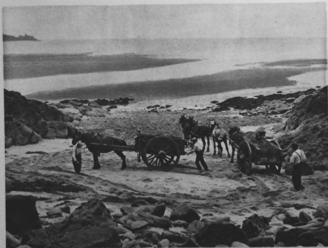
CHARGEMENT DE SABLE À LA BAIE DE LA FRESNAYE.
